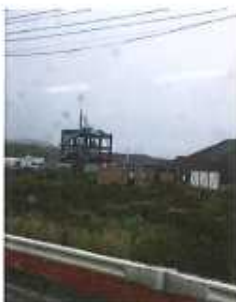
車窓からの南三陸町 防災庁舎
