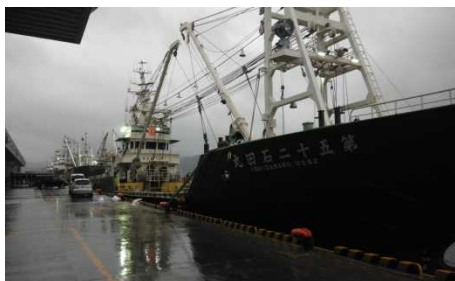
石巻港のかさ上げされた岸壁
