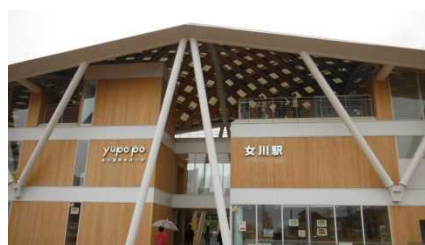
復旧したJ R女川駅舎
