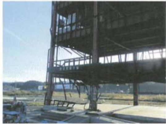
防災対策庁舎ー正面 気づきの多い現場だった。
