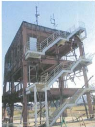
防災対策庁舎ー屋上へ繋がる階段 自然の脅威を痛感した。
