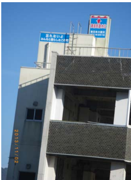
↑津波到達水位が表示された 3 F 建ビル
